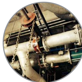
Шиберная ножевая задвижка Ду150 со штурвалом с цепью.
