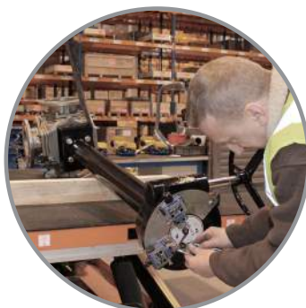
Установка и регулировка концевых выключателей на 3-х ходовом шаровом кране Ду80 с механическим редуктором и колонкой управления.
